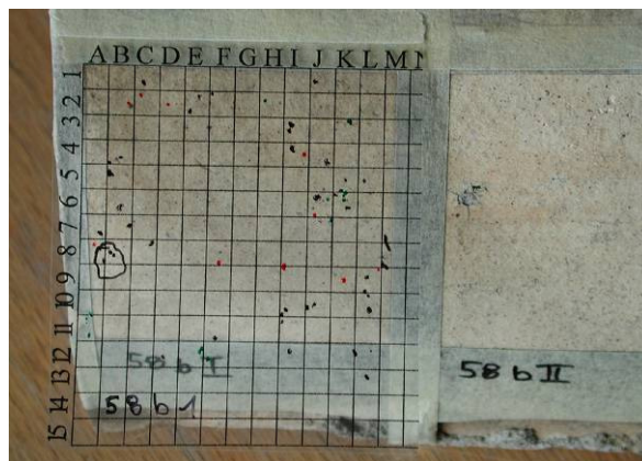
Abb. 86: Rasterfolie mit Kartierungsmarkierungen auf einem Element des Albanischen Gitters
