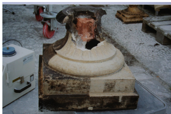
Abb. 94: Erste Probereinigung vor-Ort
