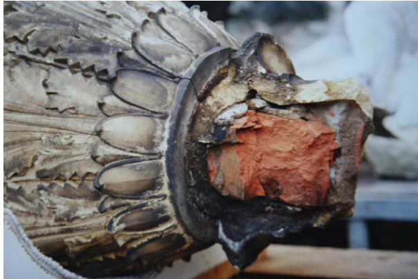
Abb. 95: Ziegelstein als Versatzhilfe
