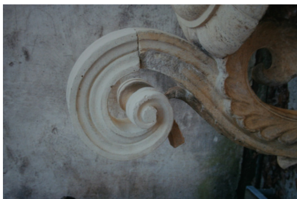
Abb. 104: Formergänzung (Ansatz Kunststeinvolute)
