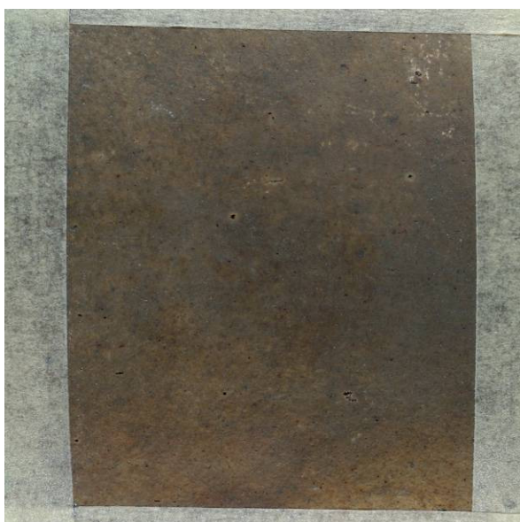
Testfläche 55 b I - Vorzustand
