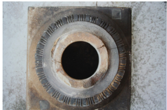
Abb. 99: Sockel nach mechanischer Reinigung
