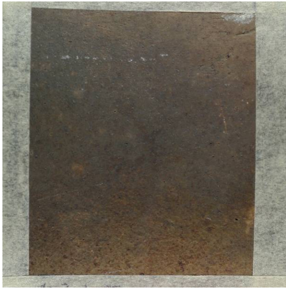
Testfläche 43 b I - Vorzustand
