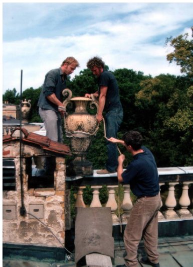
Abb. 93: Demontage der Amphoren
