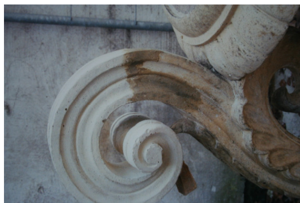
Abb. 105: Formergänzung (Überarbeitung Ansatznaht)
