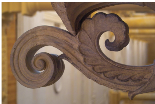
Abb. 106: Formergänzung (Farbretusche des Kunststeins)
