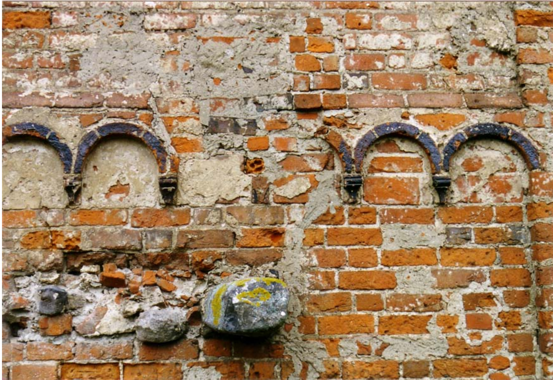
Abb. 1: Wandpartie des Alten Oberen Tores der Burg Stargard. Unter den glasierten Bögen befinden sich mittelalterliche Putze mit Ritzungen, die sogen. Wappenfrieze. Obwohl die glasierten Bögen teilweise abgeschlagen wurden, ist der Putz in einem Fall noch vergleichsweise gut erhalten (s. Abb. 2).
