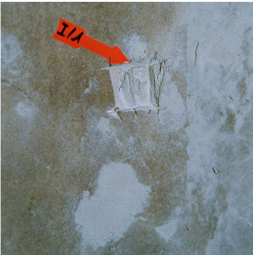
Abb. 42: Entnahmestelle der Probe I/1 (Testfläche A1) nach der Probenentnahme. Die Probe wurde mittels einer Minitrenn- scheibe herausgeschnitten.
