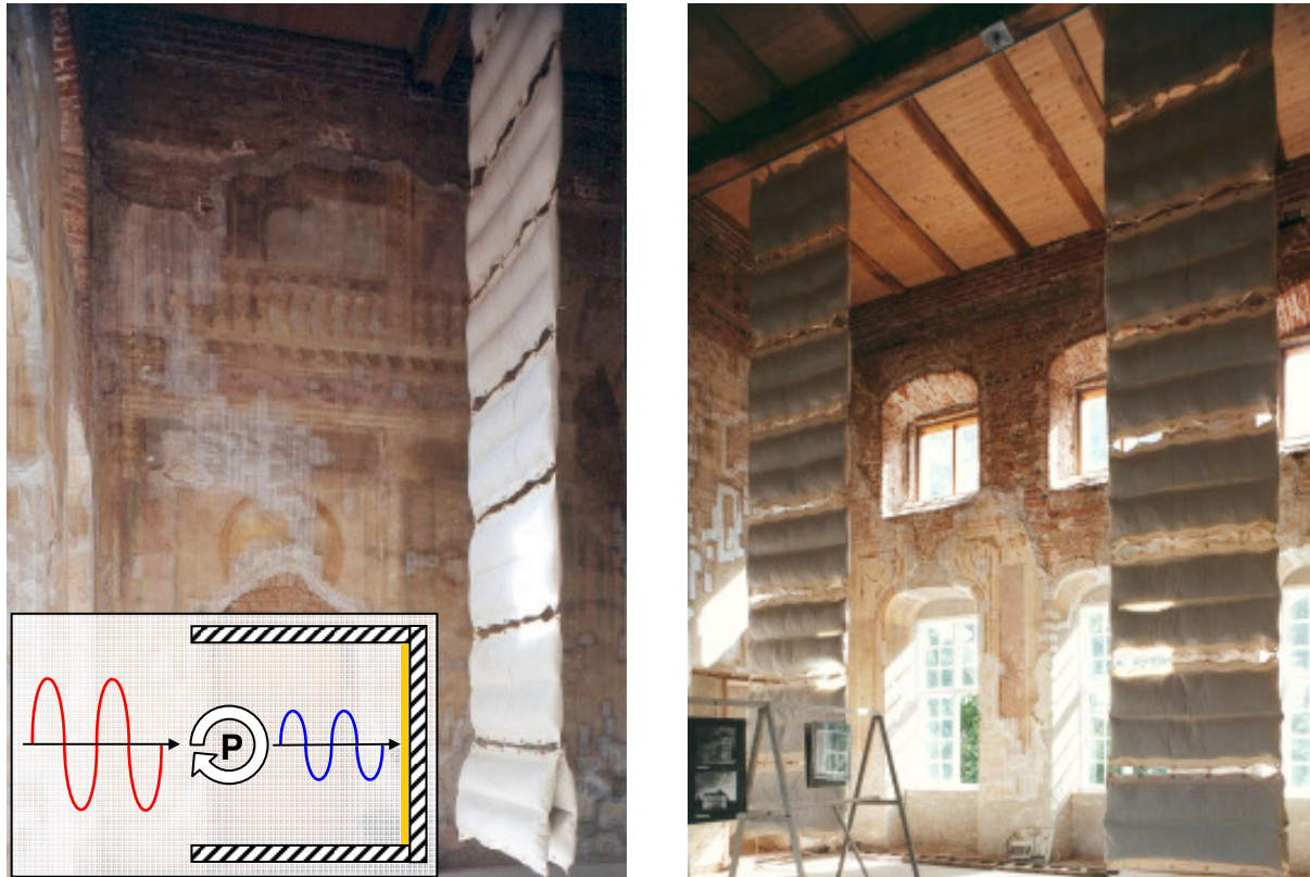
Abb. 76 und 77: Feuchtepuffer im Rokokosaal mit Prinzipskizze zur Wirkungsweise
