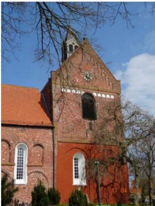
Abb. 3-1: Schlämmen im unteren Turmbereich.
