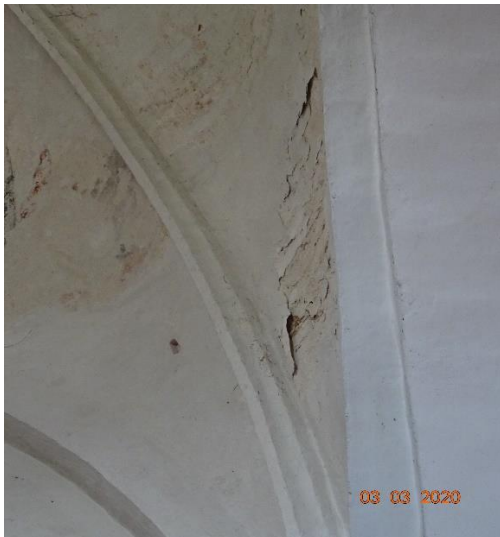
Abb. 6-2: Flächige Putzabplatzungen.
