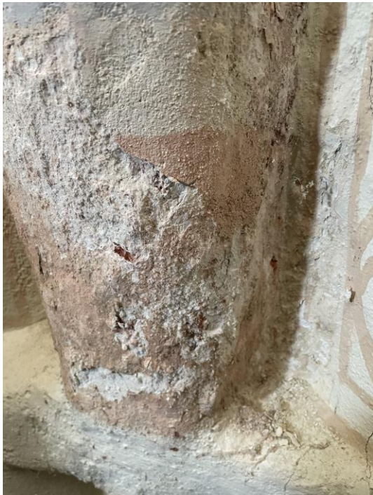
Abb. 3-24: Foto der Gurtrippe (links) und Ergebnis der ECOS-Runsalt Berechnung aus den Werten der Ionenanalyse (20 °C, rechts) einer Salzprobe aus dem links gezeigten Bereich.
