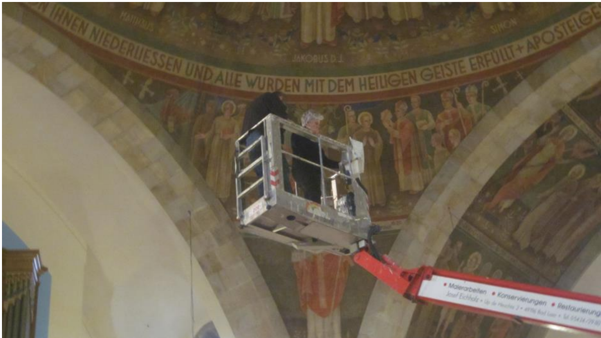
Abb. 1-8: Spruchband in Osnabrück vom Hubsteiger aus ohne Einrüstung zugänglich (Bild Jakobs).
