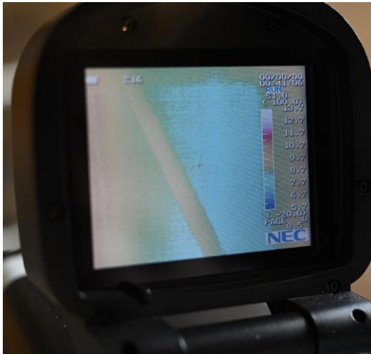
Abb. 4-5: IR-Aufnahme NO-Ecke mit starkem OF-Temperaturabfall zur Gebäudeecke (NO, rechts) hin.
