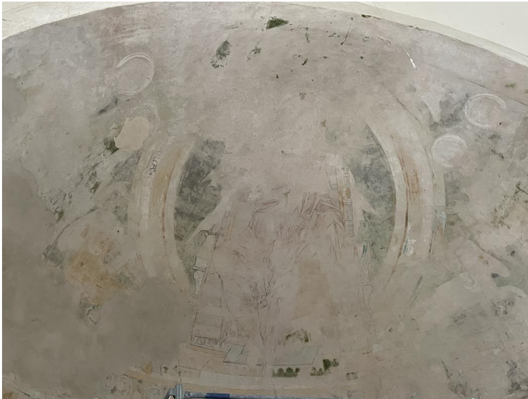
Abb. 3-21: Foto der Probenahmestelle im Bereich der Malerei (Apsis Putz mit und ohne Algenbewuchs).
