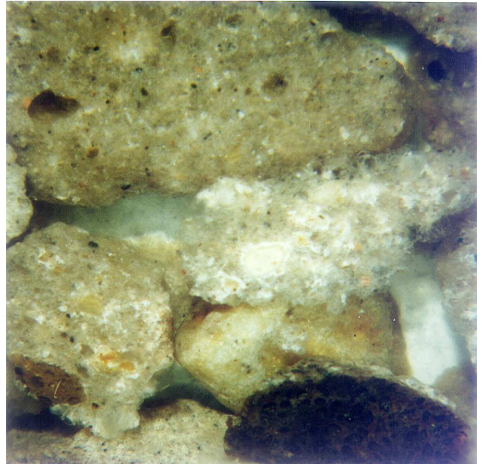
Abb. 3: Betonbruch/Matrixfraktion überwiegend bestehend aus reiner Zementsteinmatrix SteMi-Aufnahme: 8x
